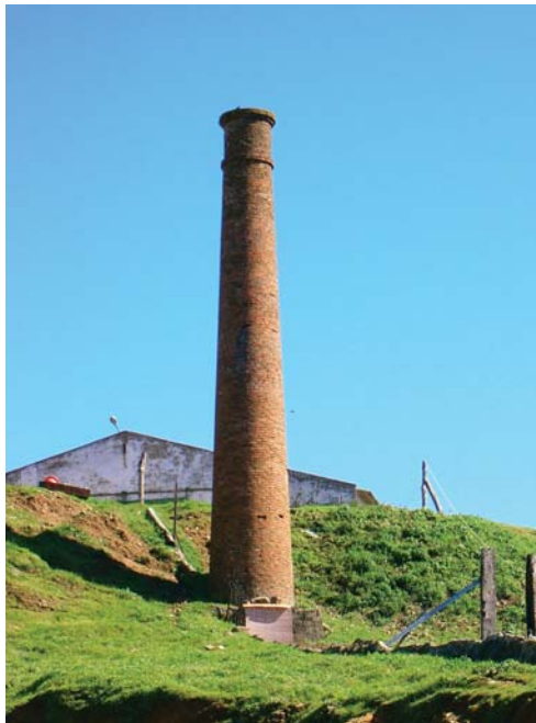
Fotografía 6. Patrimonio minero: Chimenea de fundición de El Repilado.
