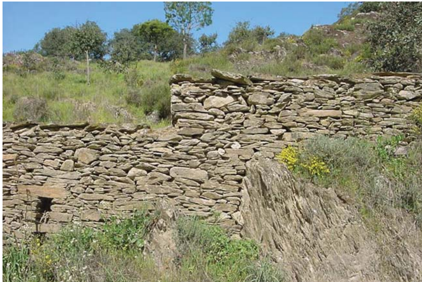
Fotografía 8. Utilización de elementos geológicos: portillos de piedra.
